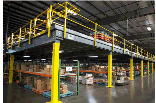
Hệ kho Mezzanine
