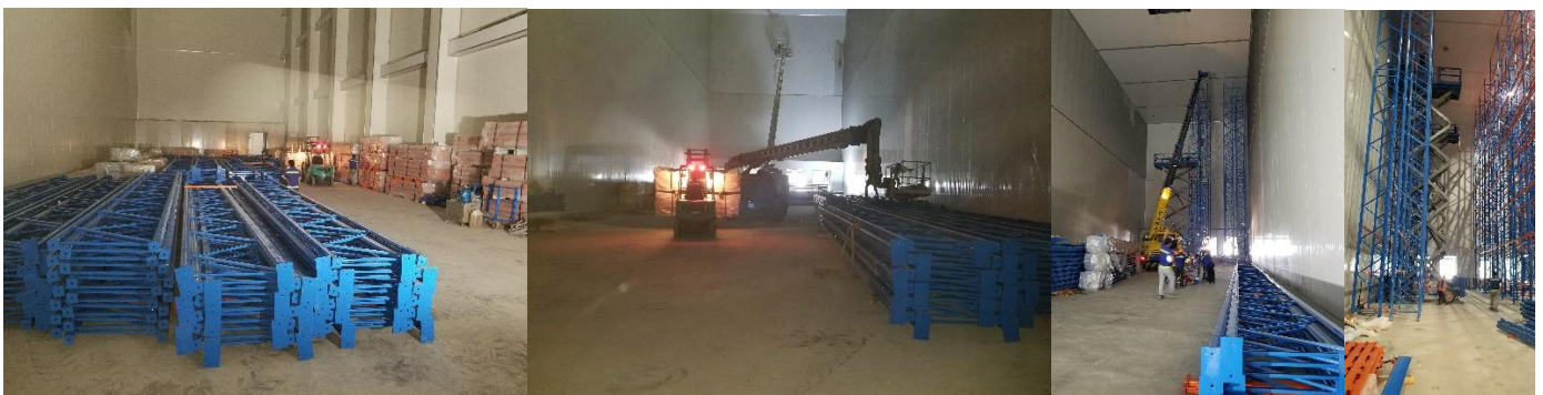
Lắp đặt kho ASRS
