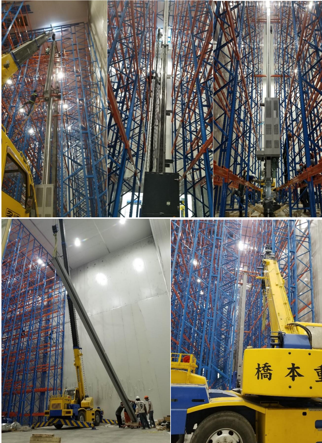
Thi công lắp đặt kệ và robot cho hệ kho ASRS
