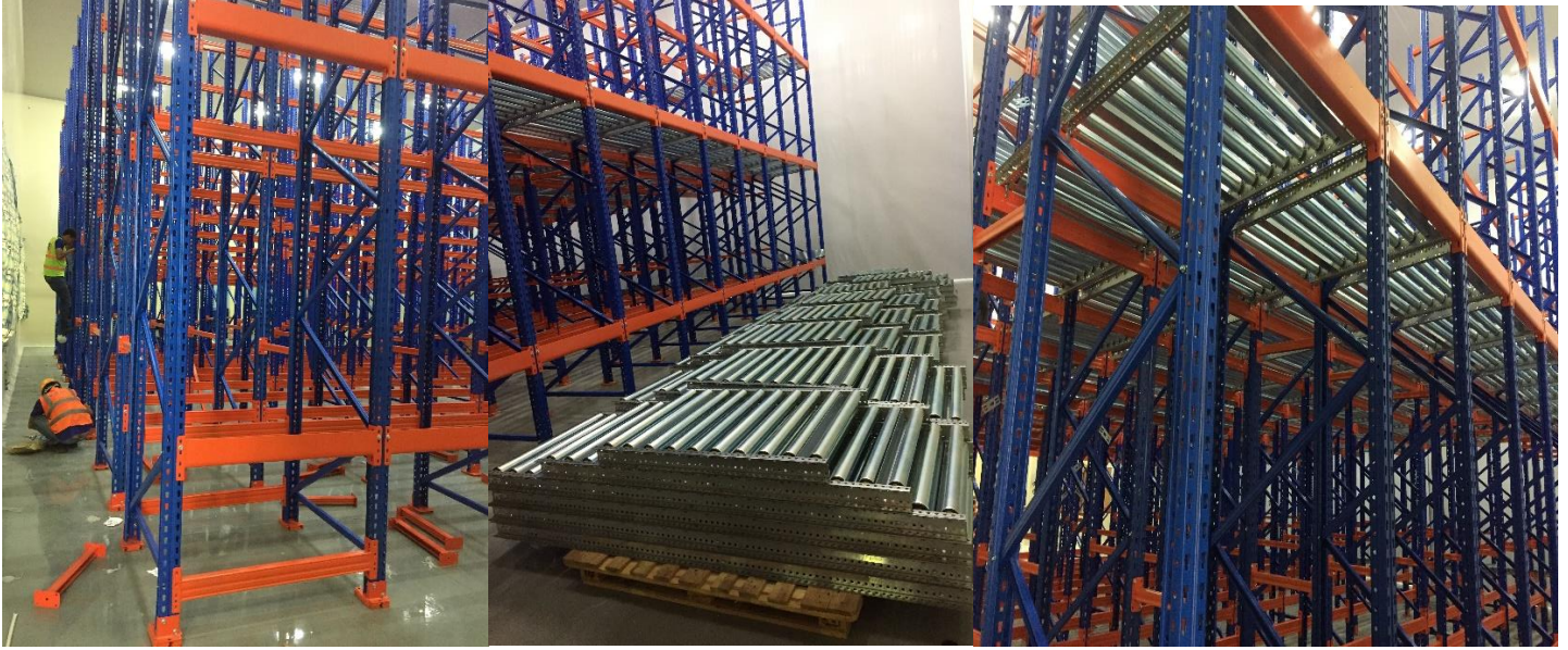
Lắp đặt hệ kho Pallet Flow
